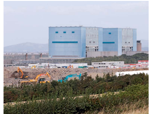
Seid verschlungen, Milliarden! Die Baustelle des britischen Atomkraftwerks Hinkley Point C
